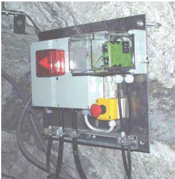
Abb.: die Kompakt-Blitzleuchte PY X-S-05 im Tunnelleinsatz, Eingangsspannungsbereich: 70–264 V AC / 73–140 V DC (Netz/Batterie)
